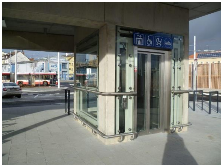
Obrázek 32: Výtah zajišťující bezbariérový přístup, Zdroj: web ukep.eu
