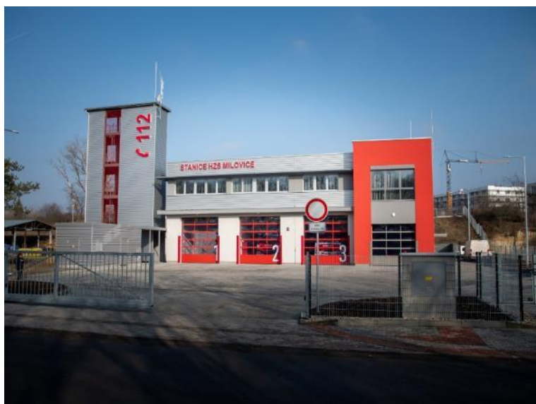
Obrázek 61: Stávající stav stanice HZS Milovice, Zdroj: web hzscr.cz
