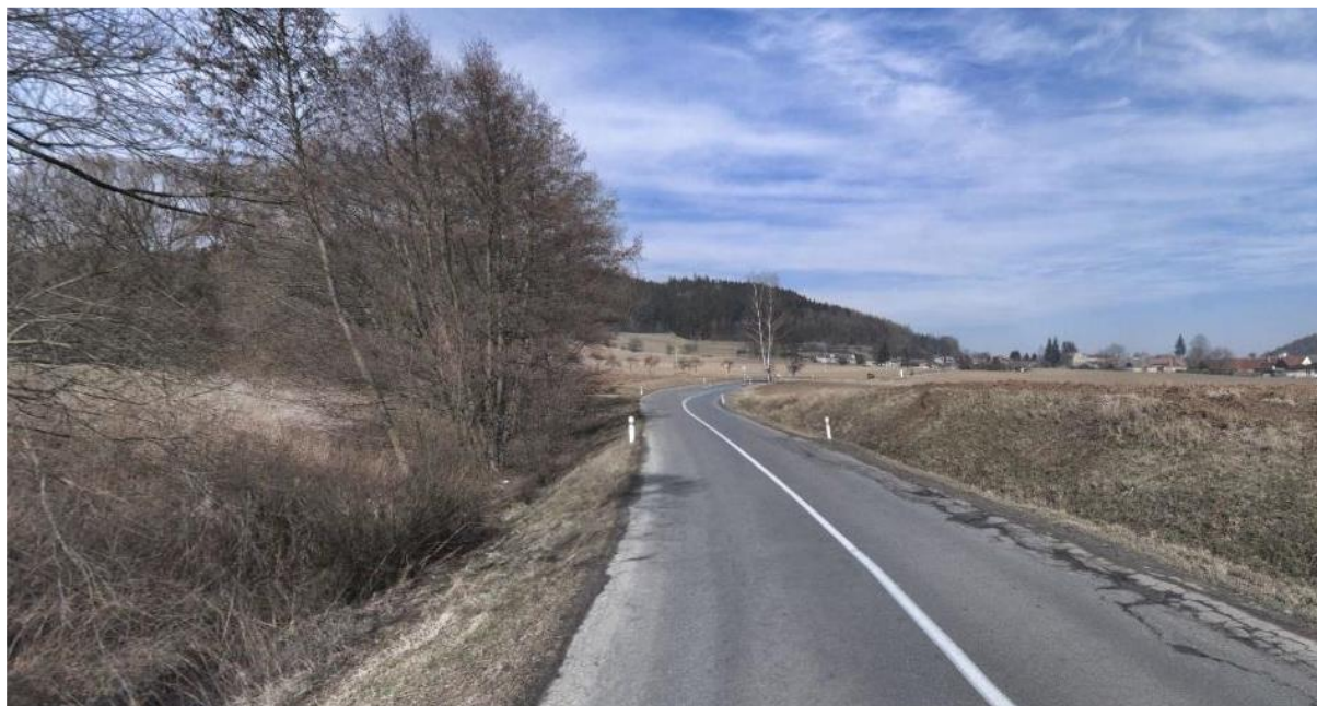
Obrázek 30: Původní stav silnice II/371. Zdroj: Studie proveditelnosti
