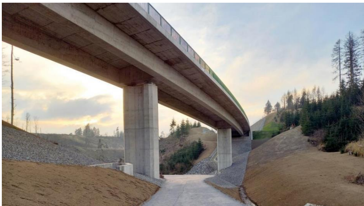
Obrázek 10: Most přes údolí levostranného přítoku Henčovského potoka v km 0,787. Zdroj: COLAS.CZ, a. s.
