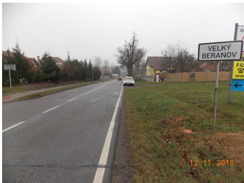
Obrázek 8: Původní II/353 v průtahu Velkým Beranovem I. Zdroj: Studie proveditelnosti
