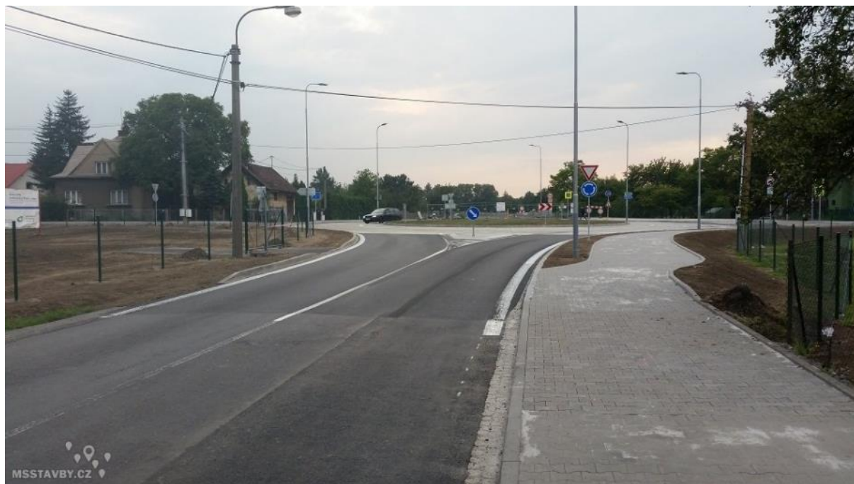
Obrázek 23: Kruhový objezd na ulici Paskovská v rámci realizace projektu Prodloužení ulice Mostní. Zdroj: MSstavby.cz
